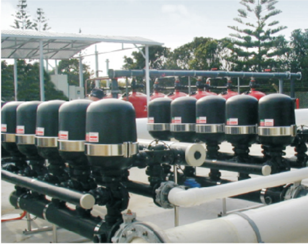
450 m 3 /saat - 55 mikron Balık Çiftliği - Deniz Suyu Filtrasyonu
