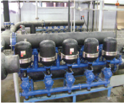
Soğutma Suyu Filtresi 350 m 3 /saat - 100mikron
