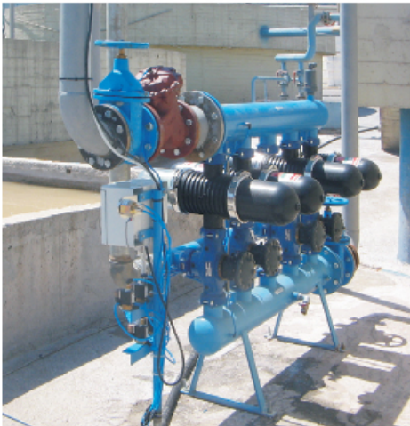
450 m 3 /saat - 55 mikron Balık Çiftliği - Deniz Suyu Filtrasyonu
