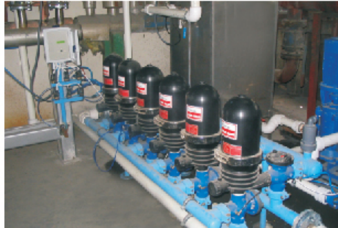
Soğutma Suyu Filtresi 30 m 3 /saat - 20mikron
