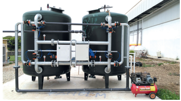
Resim 3. Dış Tabiat Şartlarına Uygun Olarak İmal Edilmiş Su Yumuşatma Cihazı
