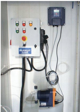
Resim 1. Hassas Ölçümlü Otomatik Su Klorlama Sistemi
