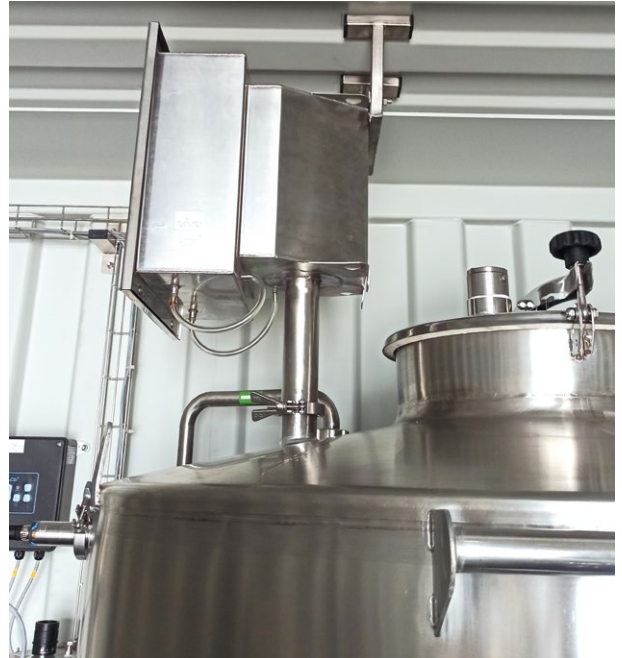
Resim 2. Hassas Hava Filtresi ve Vakum Kontrolü ile Donatılmış Su Tankı
