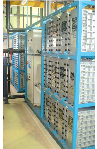
Resim 1. Saf Su Üretimi için EDİ Sistemi 2 x 50 m 3 Saat
