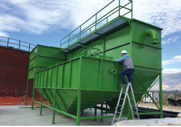
Resim 2. Sudaki AKM'yi Azaltmak için Kurulan Çöktürme Sistemi
