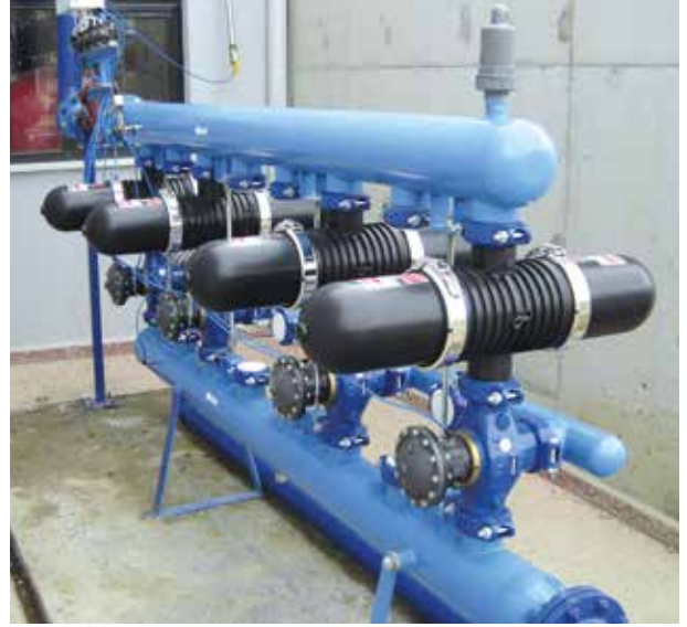
Resim 5. Yağmur Suyu için 400 Mikronluk Diskli Filtre
