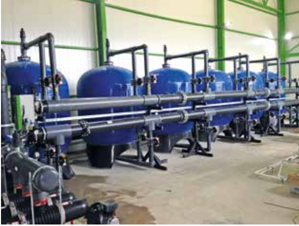
Resim 2. Çok Birimli Kum Filtresi Sistemi 200 m³/Saat
