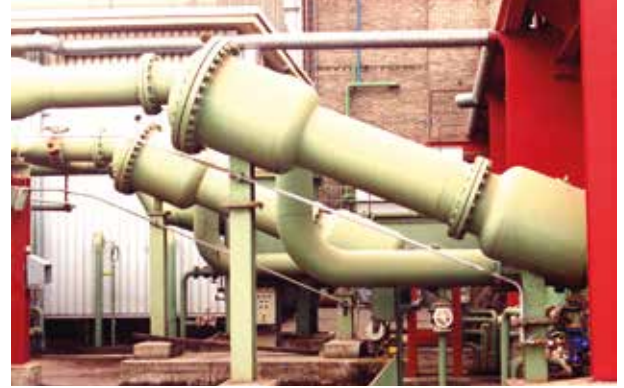
Resim 3. Tufallı Su için Katı Ayırıcı 2 x 2000 m³/Saat
