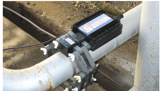
Radyo frekansı ile soğutma suyunda kireçlenmeyi ve yosun oluşmasını önleyen frekans jeneratörü
