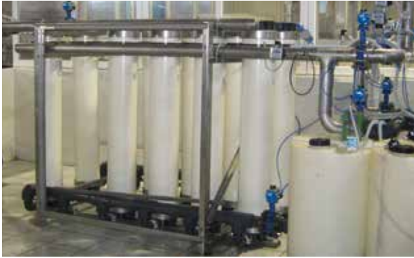
Resim 5. Ultra Filtrasyon Sistemi 40 m³/Saat
