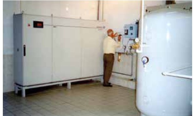
Resim 1. Donmuş Gıda İşletmesinde Ozon ile Su Dezenfeksiyonu Sistemi
