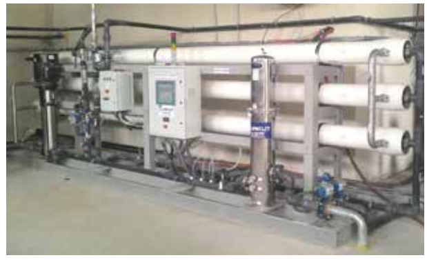
Resim 7. Gıda İşletmesi için 20 m³/Saat Proses Suyu Üreten Ters Ozmoz Cihazı
