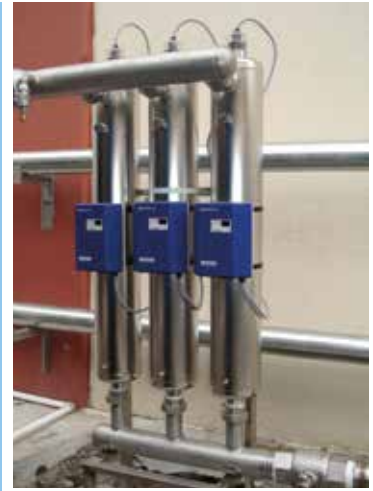
Resim 4. Prosese Giden Suyun Ultra Viyole Işını ile Dezenfeksiyonu
