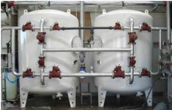
Resim 6. Su Yumuşatıcı 40 m³/Saat
