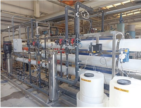
Resim 4. Su Geri Kazanım için Özel Tasarım Ters Ozmoz Cihazı
