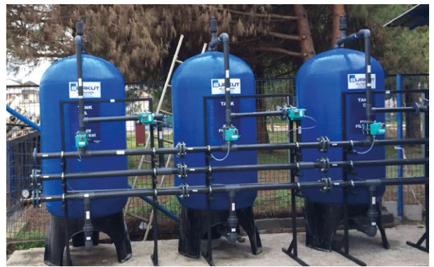
Resim 3. Soğutma Sularının Böbrek Filtre Yöntemi ile Filtrasyonu için Tasarladığımız Özel Dolgulu Çok Tanklı Kum Filtresi
