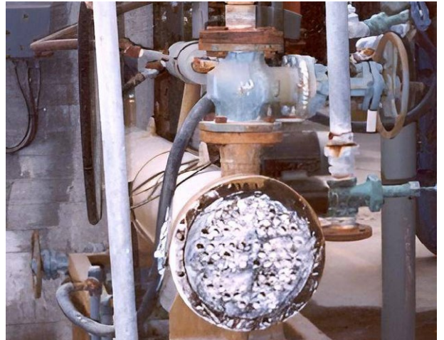
Resim 4. Doymuş Su Kullanımı Sonrası Kireç ile Tıkanmış Eşanjör
