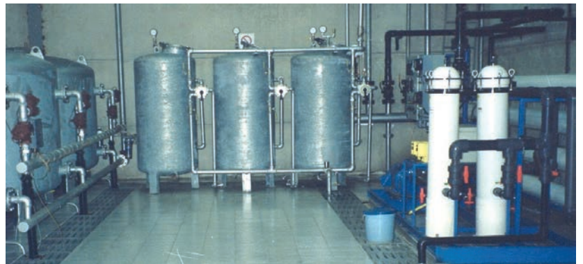
24 m³/saat kapasiteli Ters Ozmoz Sistemi
