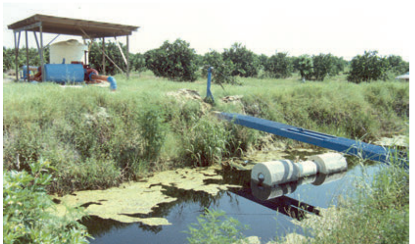
Otomatik temizlemeli pompa koruma filtresi
