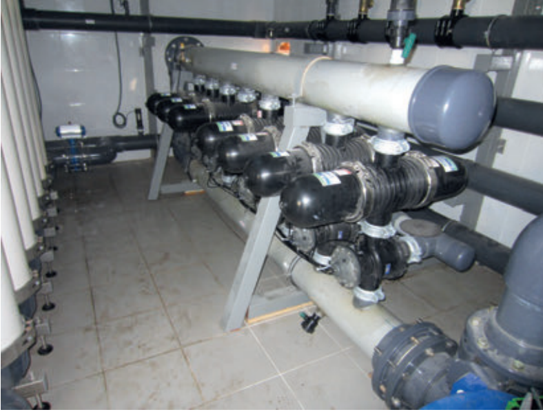
Ultra Filtrasyon Koruyucu Diskli Filtre
