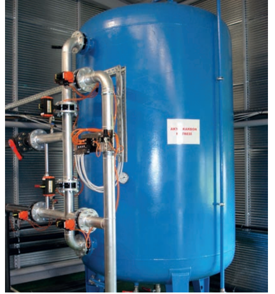
Resim 4. Epoksi Kaplamalı Çelik Tank ile İmal edilmiş Aktif Karbon Filtresi
