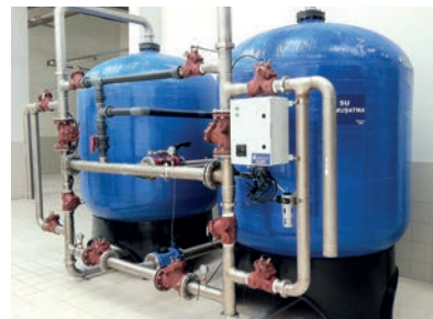
Resim 2. CTP Tanklar ile İmal Edilmiş Su Yumuşatıcı
