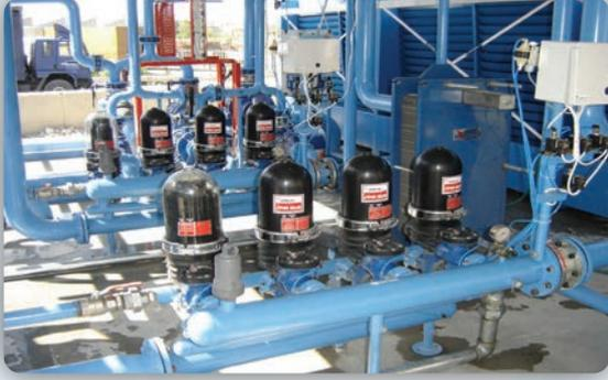
Soğutma Suyu Filtrasyonu için
