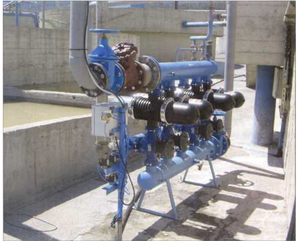
(Resim 5) Diskli Filtre Atık Arıtma Tatbikatı, 100 \text{ m}^3/\text{saat} 100 mikron
