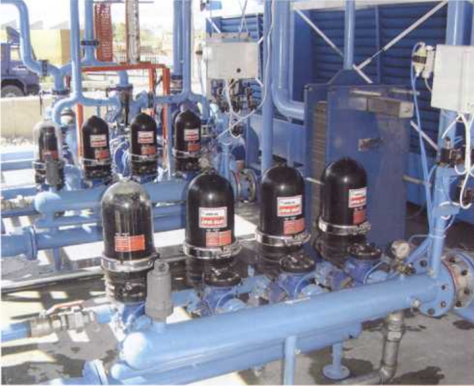
(Resim 2) 2 x 4 Birimli Modüler Diskli Otomatik Filtre
