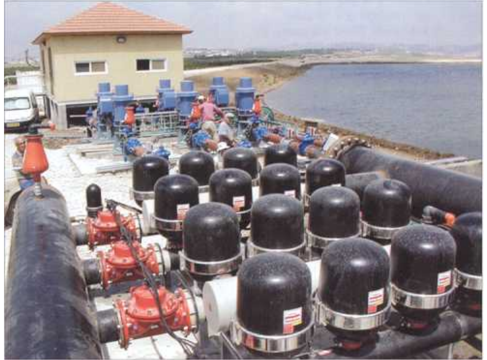
(Resim 3) Yüksek Debiler için 5 Modüllü Gruplardan oluşan Diskli Otomatik Filtre, 1200 m^3/saat – 130 mikron
