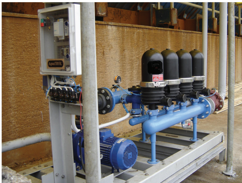
Isı eşanjörü koruyucu filtre uygulaması 65 m 3 /saat.
