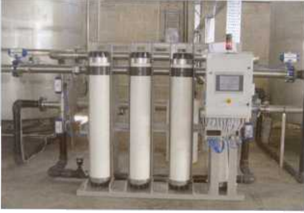
Ultra filtrasyon ile kaynak suyu filtrasyonu
