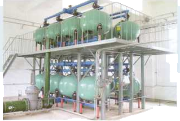
Yeni nesil modüler kum filtreleri ile içme suyu filtrasyonu
