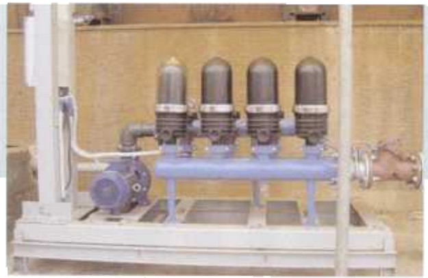
Diskli filtre ile soğutma suyu filtrasyonu
