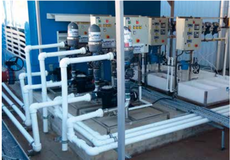
Resim 7. Kule Koruyucu Tam Otomatik Kimyasal Dozaj ve Kontrol Sistemi
