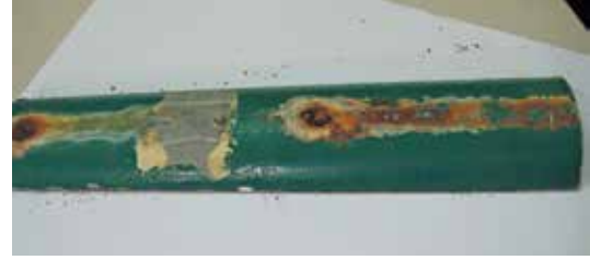
Resim 6. Soğutma Suyu Borularında Korozyon Sonucu Delinmeler
