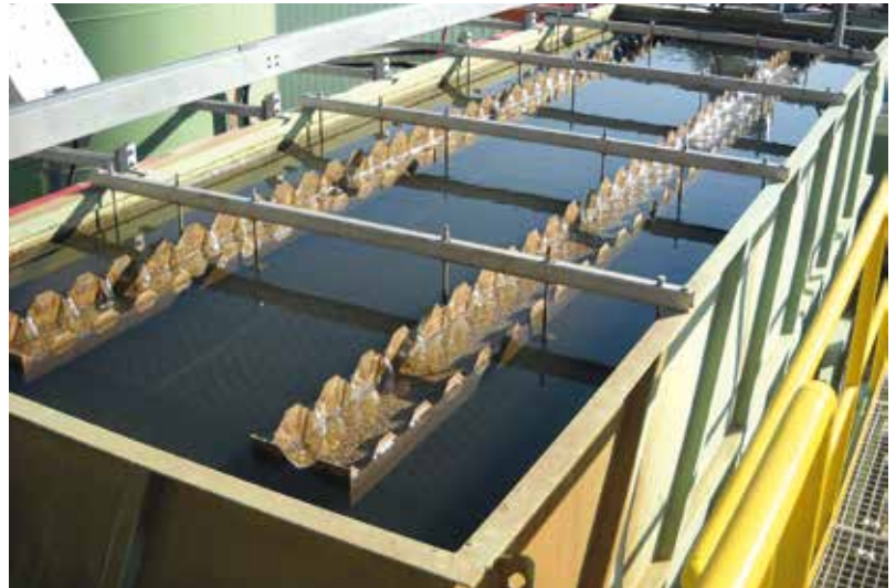
Resim 2. Kimyasal Katı Çöktürme Sistemi
