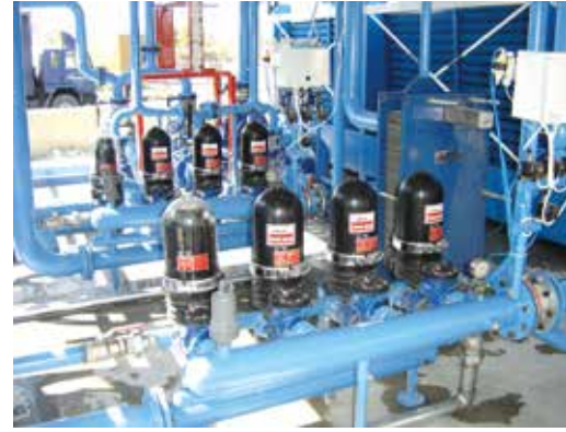
Resim 6. Tam Otomatik Ters Yıkamalı Filtre
