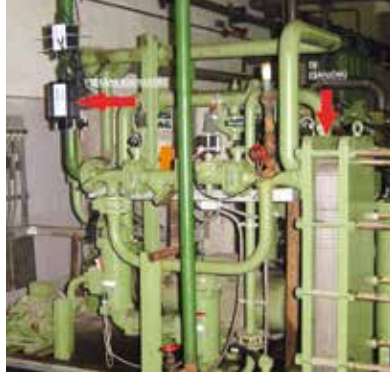
Resim 8. Kireçtaşı Önleyici Frekans Jeneratörü
