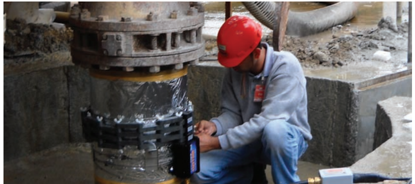
Frekans tekniği ile ısı eşanjörünün kireçten korunması
