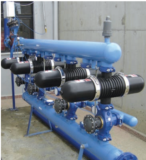
UF Ön Filtresi Olarak Diskli Filtre
