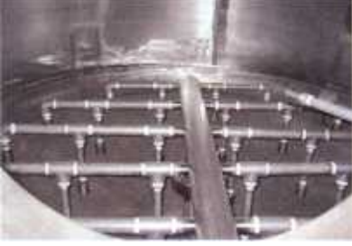
Şekil 1. Tabanında "yeterli fiskiye bulunmayan" kum filtresi. 2,20 m çaplı filtre tabanında 40 adet fiskiye (difüzör) bulunuyor.
