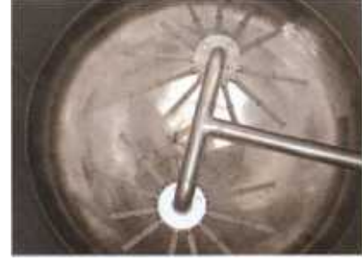
Foto 1. Tabanında yeterli fiskiye bulunmayan, kumun tamamı kullanılmayan kum filtresi.
