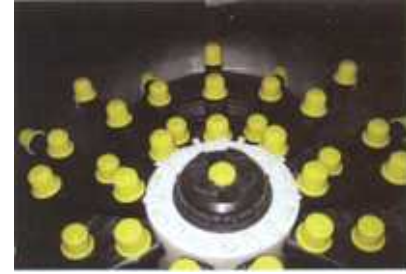
Foto 2. Tabanında çok miktarda fiskiye bulunan, kumun tamamı kullanılan kum filtresi.
