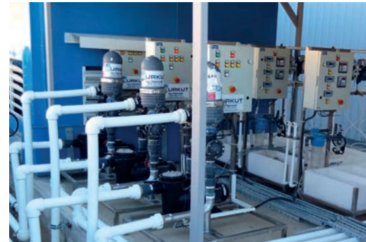
Soğutma Suyu için Tam Otomatik Kimyasal Dozaj Sistemi
