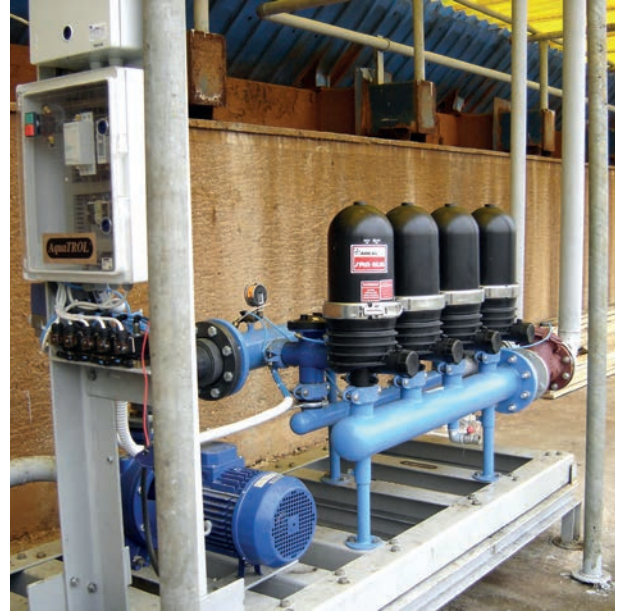
Soğutma Kulesi Havuzlarını Hareketli Tutan ve Suyu Filtreleyen Diskli Böbrek Filtre
