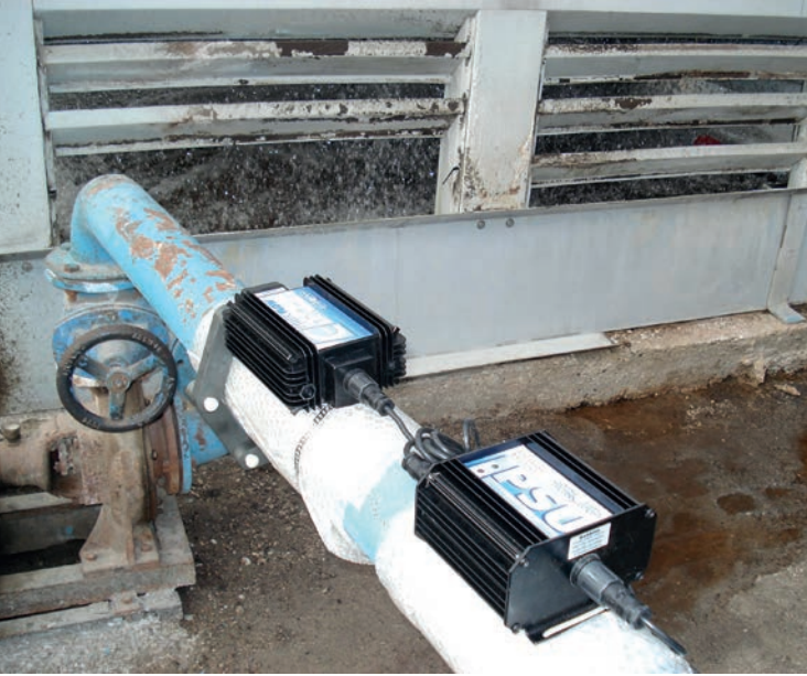
Frekans Tekniği ile Kireçlenmeyi Engelleyen Cihaz
