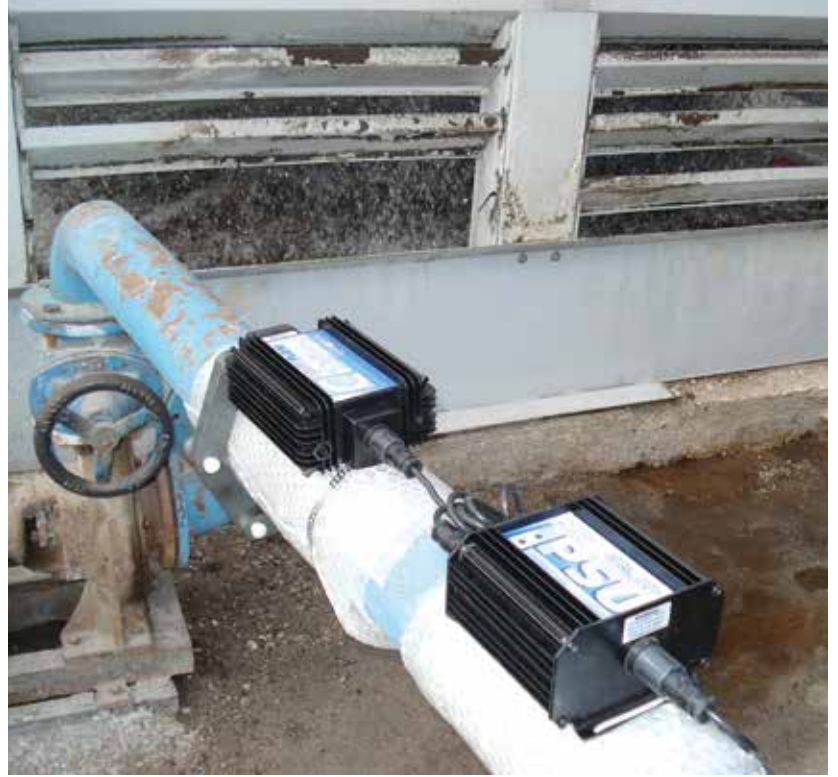
Soğutma suyunda FREKANS tekniği ile yosun mücadelesi
