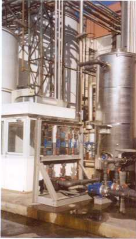
Kuyu suyunda demir ve mangan giderimi için ozon gazı tatbikatı.
