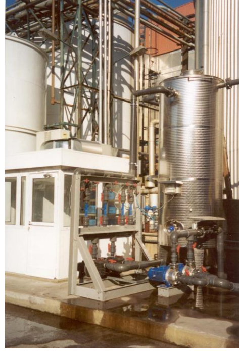
Resim 2. Kuyu suyunun Ozon ile dezenfeksiyonu sistemi
