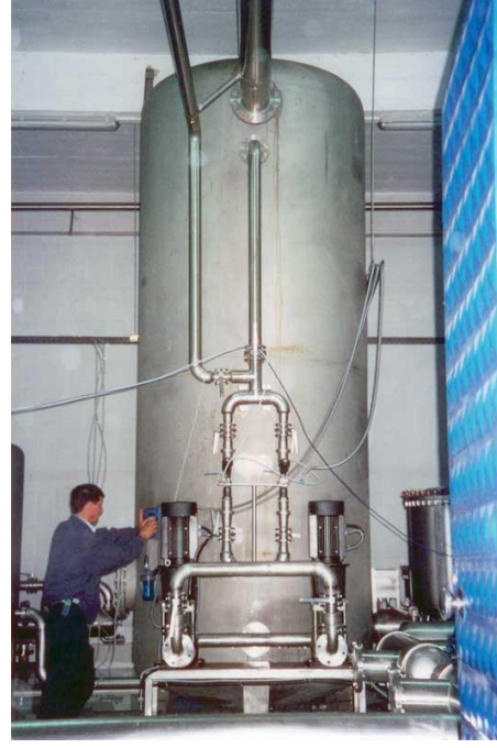
Resim 3. Basınç Altında Su Ozonlama Sistemi
