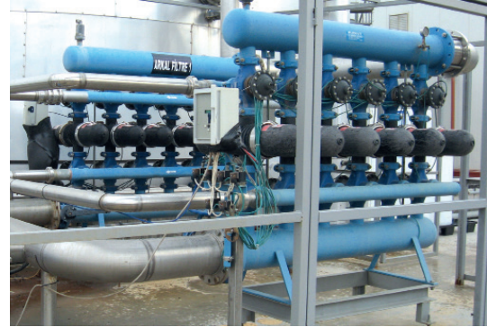
Ham Su Deposu Girişinde Diskli Filtre 2 x 120 m 2 Saat
