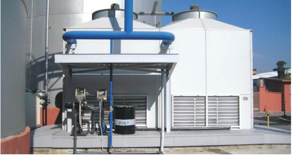
Resim 4. Tam otomatik ters yıkamalı soğutma suyu servis hattı filtresi
