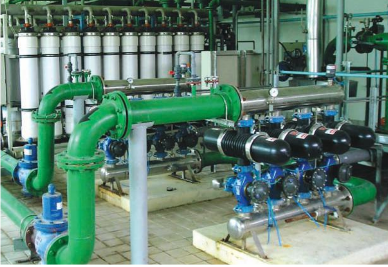
Resim 1. Mekanik filtre arkası ultra filtrasyon ile kademeli filtrasyon
