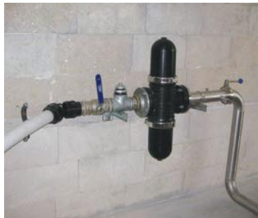
Resim 3. Katı tutma hacmi geniş ve el ile kolay temizlenen filtre
