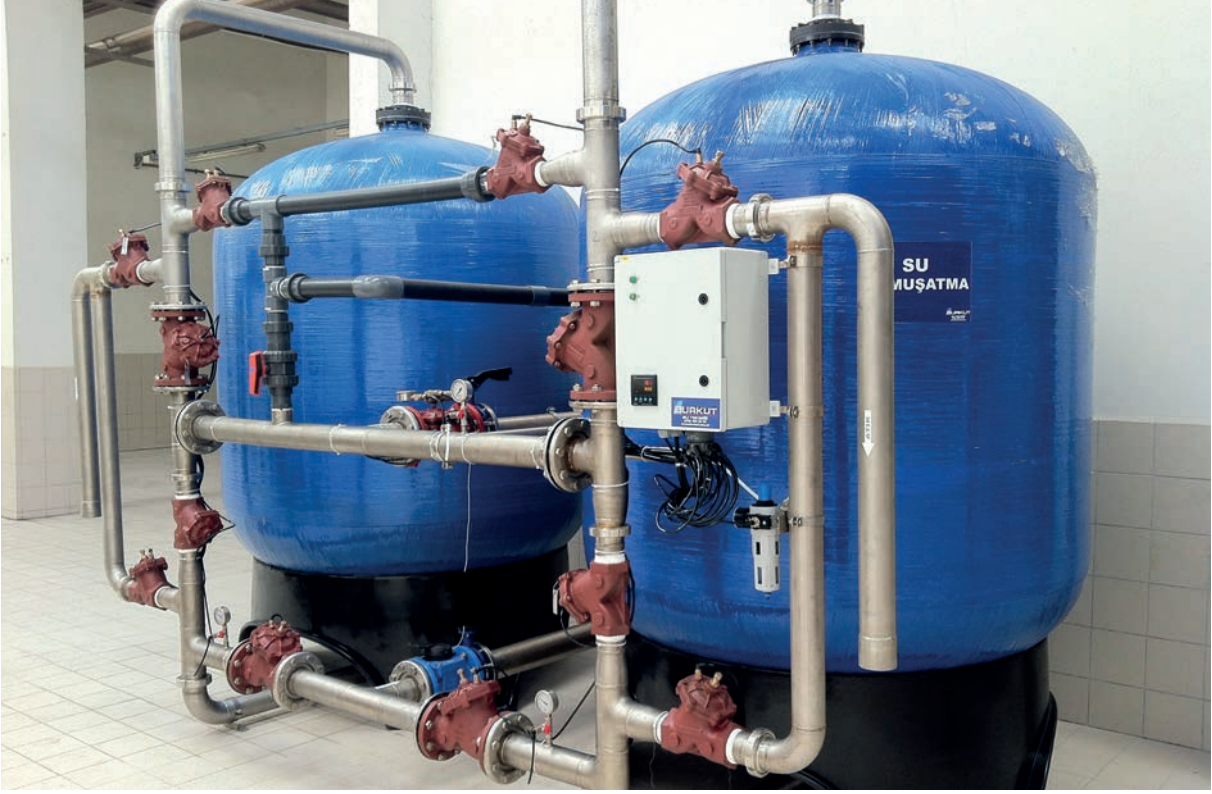
Resim 4. Sanayi işletmesinde sorunsuz görev yapan TEK YOLLU vanalar ile donatılmış tandem su yumuşatıcı
