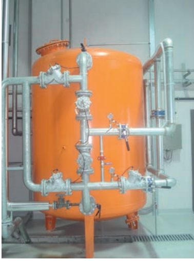
Resim 1. Bireysel tek yöllü diyaframli otomasyon vanaları ile donatılmış kum filtresi
