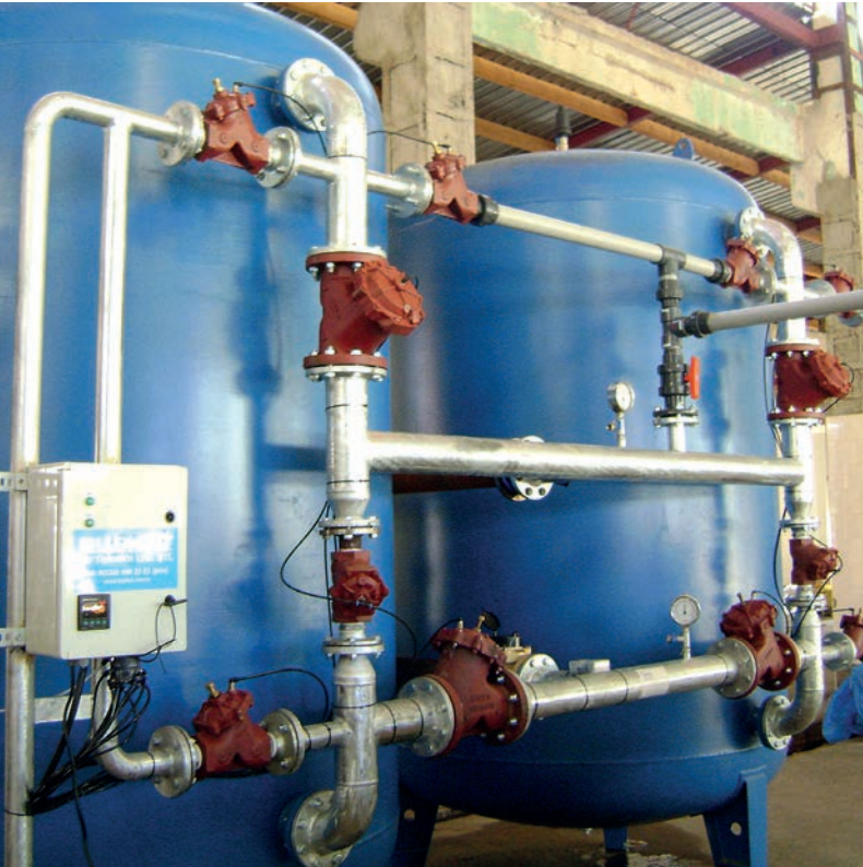
Resim 2. Bireysel tek yöllü diyaframli vanalar ile donatılmış tandem yumuşatıcı
