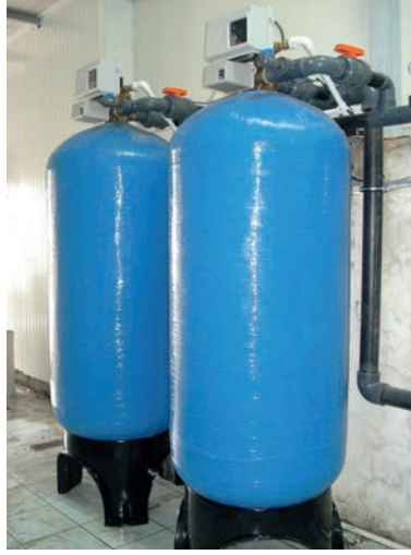
Resim 3. Çok yöllü vana ile donatılmış tandem yumuşatıcı
