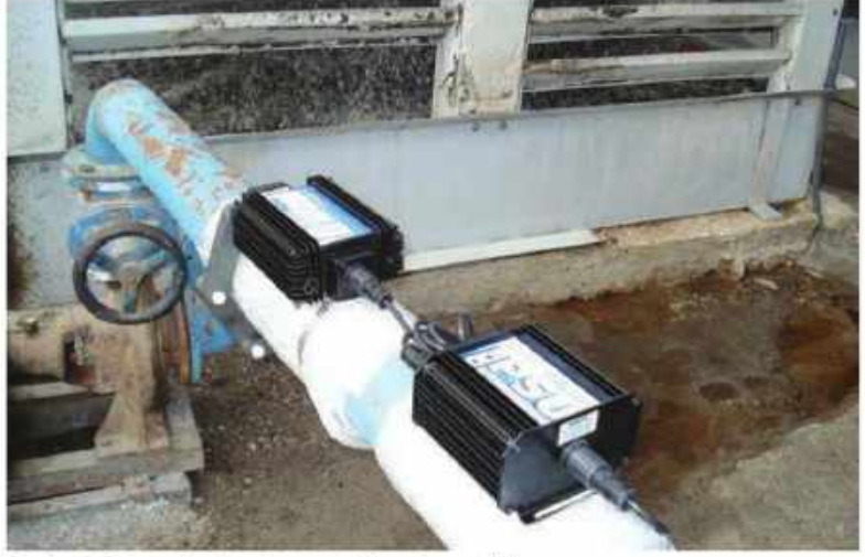
Resim 2: Soğutma kulesini koruyan frekans jeneratörü
