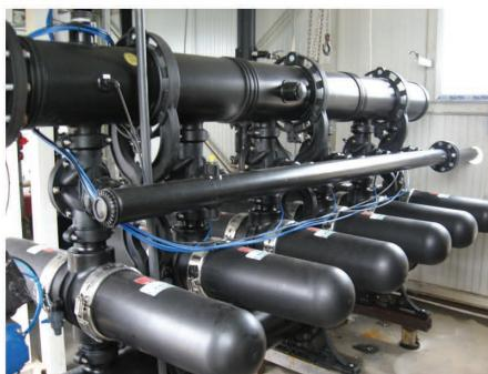
Soğutma suyu için diskli filtre,  $300 \text{ m}^3/\text{saat}$
