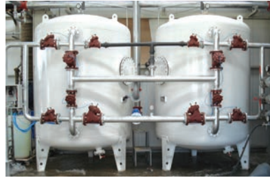
Resim 2. İki yollu vanalar ile donatılmış metal tanklı yumuşatıcı
