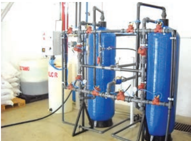
Resim 1. İki yollu vanalar ile donatılmış sentetik tanklı yumuşatıcı
