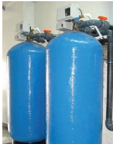
Resim 3. Çok yollu vanalı yumuşatıcı
