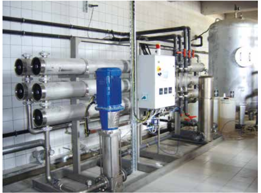
Resim 4: Ters Ozmoz tekniği ile sudaki azotlu maddelerin giderimi
