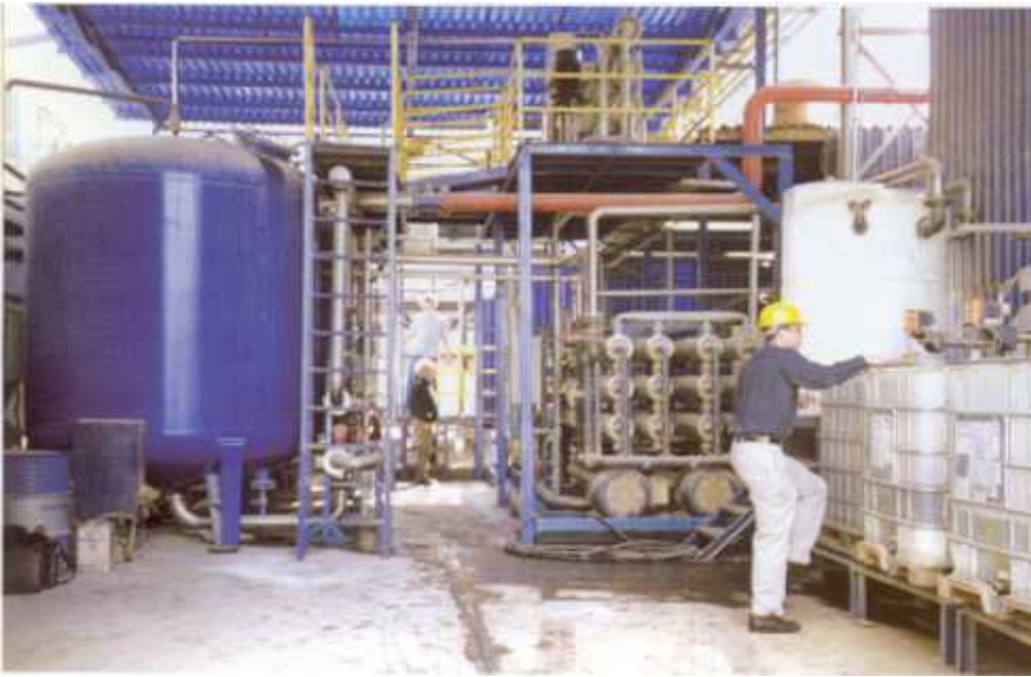
Ters Ozmoz Sistemi, kum filtreleri, kimyasal dozaj sistemleri ve kimyasal saklama tankı ile beraber
