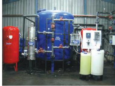
Resim 3: Ters Ozmoz Cihazı Ön Şartlandırma Sistemi
